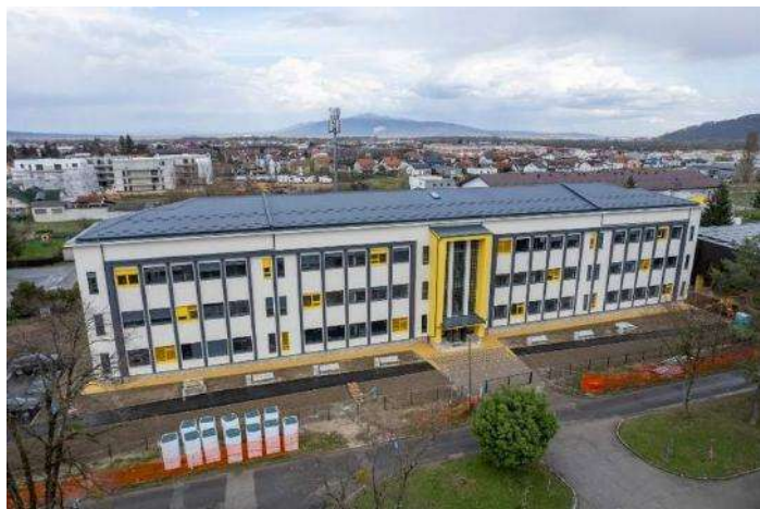
Slika 5: Nova školska zgrada u fazi radova
